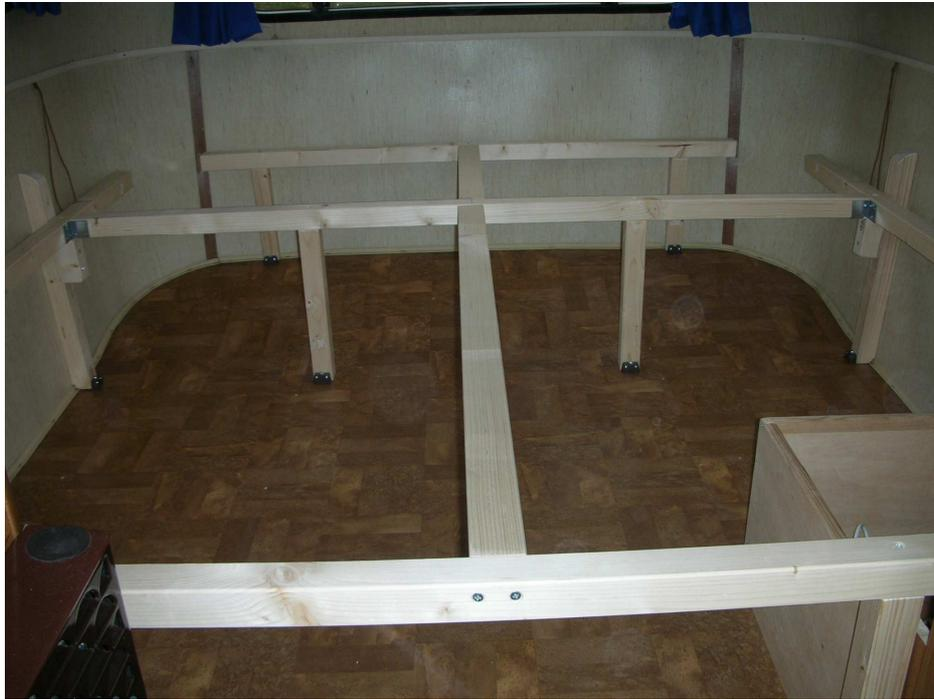
Die Konstruktion ist so ausgelegt, dass sie ausschließlich am Boden befestigt ist und sich gegen die Wände nur abstützt. Da der Touring ein Bettenmaß von 188 cm x 188 cm hat, die späteren Lattenroste und Matratzen aber dem Handelsmaß 90 cm x 190 cm bzw. 90 cm x 200 cm entspringen, habe ich links und rechts die Kanthölzer nach oben überstehen lassen, was der Zentrierung der Matratzen und der Hinterlüftung dient.
