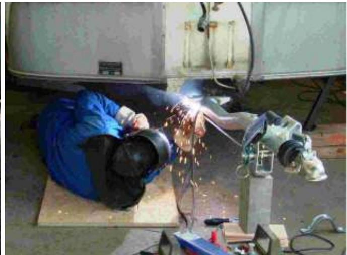
Auch die Befestigung der neuen Stoßdämpfer ist einfach. Hier kommt ein stabiler Stahlwinkel 40x45 mm in der Länge 130 mm zum Einsatz. Am Rahmen angeschweißt sieht er aus, als wäre der immer da gewesen. Schnell noch Grundierung und Lack versprühen und 5 Stunden nach Arbeitsbeginn steht der Wohnwagen zu einem ersten Fototermin vor der Halle. Ich bin begeistert, nur Sergej meint, dass wir das auch schneller könnten, wenn wir nicht so lang überlegt hätten, und meint natürlich lächelt mich damit.
