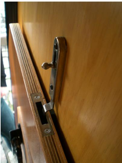
Der Beschlag (Riegel und Einlassblech) kostet etwa zwei bis drei Euro. Für die Montage muss, z.B. mit einem Stechbeitel etwas Holz herausgearbeitet werden. Ich habe die Innenseite bzw. das Loch dann Schwarz gestrichen, so sieht es noch sauberer aus.
