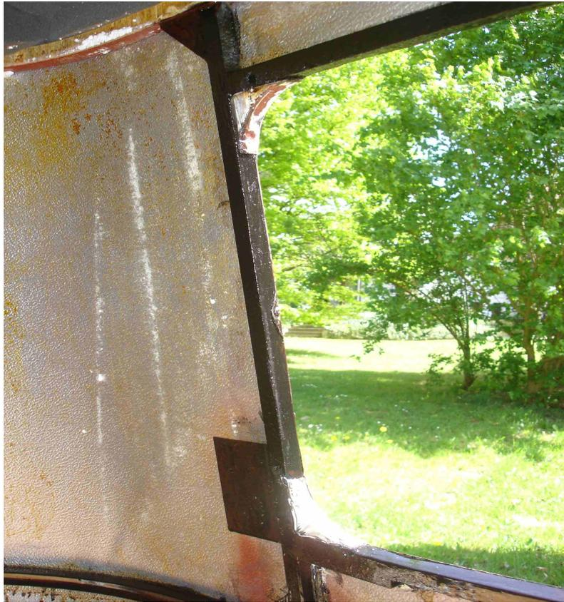
Zum isolieren habe ich 2 cm Hartschaumplatten aus dem Baustoffhandel genommen. Für alle Felder schön zugeschnitten und mit Ottocoll Allflex Montagekleber eingeklebt und noch offene Fugen mit Montageschaum ausgeschäumt. Für die runden Flächen mußte ich mehrere schmale Stücke schneiden. Nächsten Tag Kleber und Schaumreste wegschneiden.
