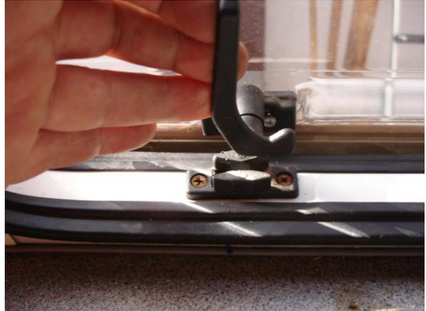
Anschließend noch den / die seitlichen Anschläge außen anschrauben – Abdichtung der Schrauben dabei nicht vergessen !
