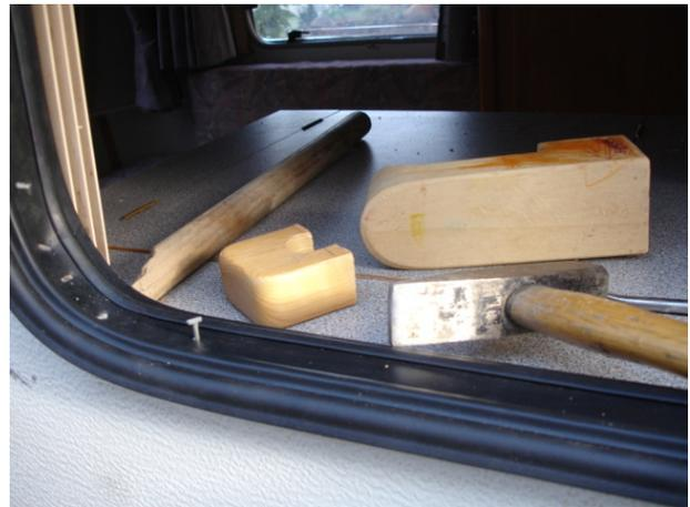
Im Bereich des Stoßes je einen Nagel setzen, damit die Dichtung hier in Position bleibt:
