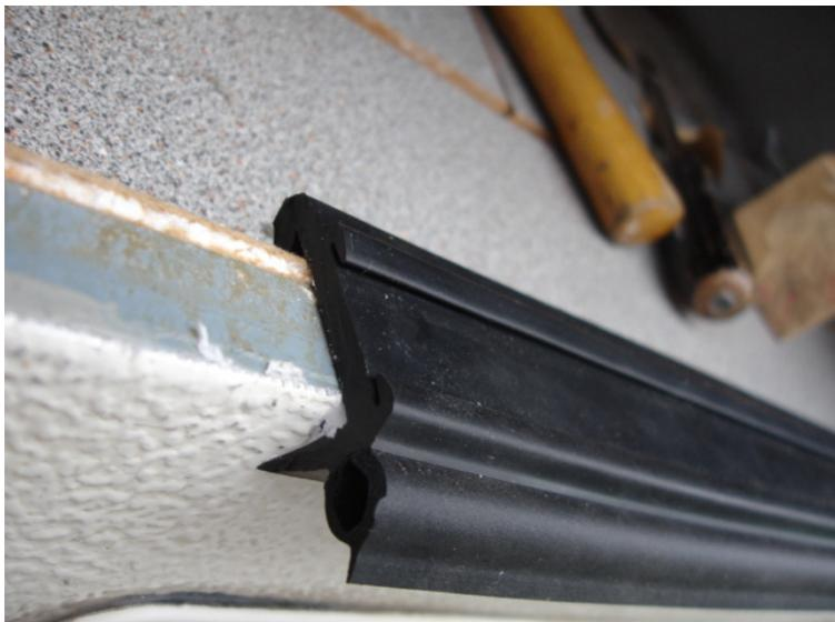
Die Dichtung dann nach und nach einbauen (am besten in einem Stück mit einem Helfer, der die Dichtung hält - so hat man den geringste Verschnitt).
